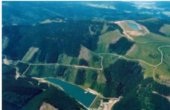
Figure 3. PSPP Dlouhé Stráně in the Czech Republic (2 x 325 MW, head 500 meters)
